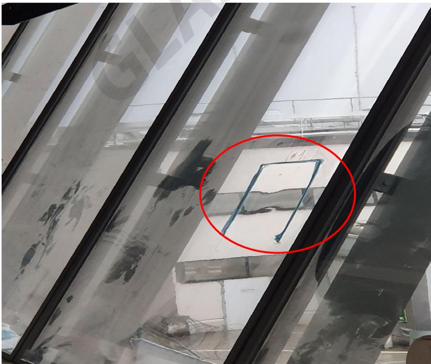
Zusätzlich werden Ceroxide Poliermittel bei zu hohen Temperaturen eingesetzt. Die trockene Bearbeitung und dadurch überhitzte Oberfläche bekommt weiß bläuliche Streifen, welche durch „Verbrennen“ der Oberfläche infolge der starken Reibung entstehen.
